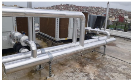
Tribunal à Tanger: Pose seulement de jackettage en alu des réseaux Eau glacée- Client Ventec Maroc
