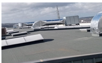
Usine Magneti Marelli à Tanger Med: Fourniture et pose Jacketage alu des réseaux aerauliques et hydrauliques- Ventec Maroc
