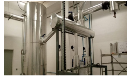
Usine SCS /TAC 35 à Tanger Med: Fourniture et pose Jackettage alu des réseaux aerauliques et hydrauliques- Ventec Maroc
