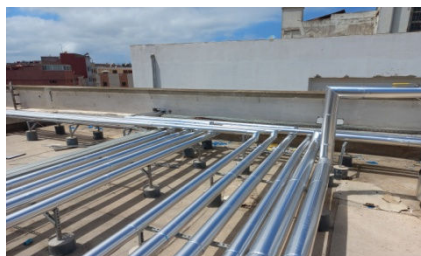
Hopital Molay Abdellah à Mohamedia: Fourniture et pose des jacketage en alu des réseaux Eau glacée- Client Thermoclim
