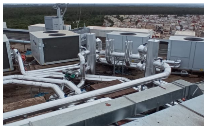
ANCFCC à Rabat: Fourniture et pose des jackettage en alu des gaines rectangulaires et réseaux hydrauliques pour Batiments IGH: Tour1 ( R+14 etages), Tour2 (R+ 6 etages), Tour 6 (R+ 7etages), Tour 7 ( R+8 etages) et Mi-centrale R+1 et travaux de jackettage en inox pour local chaufferie - Client Ventec Maroc
