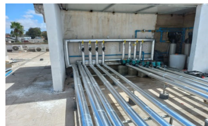
Hopital Molay Abdellah à Mohamedia: Fourniture et pose des jacketage en alu des réseaux Eau glacée- Client Thermoclim
