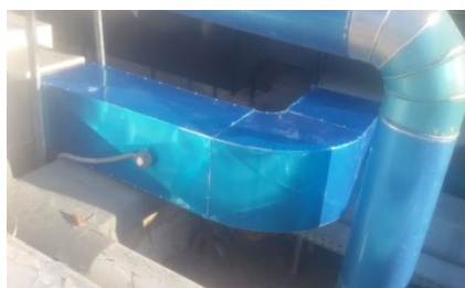
Bank Elmaghreb à Rabat: Modification de Fourniture et pose des jacketage en alu des gaines rectangulaires- Ventec Maroc
