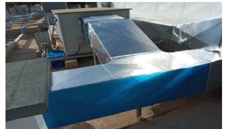
Hotel Radisson Blu Al-houciema: Fourniture et pose Jackettage alu des réseaux aerauliques et hydrauliques- Ventec Maroc
