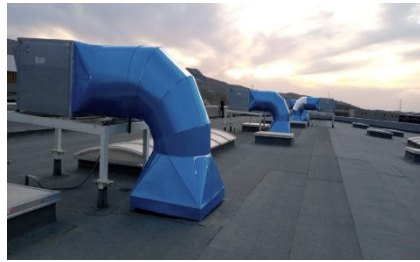
Usine SCS /TAC 35 à Tanger Med: Fourniture et pose Jackettage alu des réseaux aerauliques et hydrauliques- Ventec Maroc
