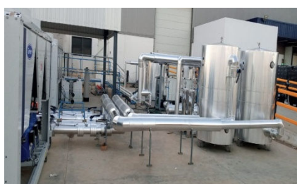
Salle Blanche à Tanger Med: Fourniture et pose Jacketage alu des réseaux aerauliques et hydrauliques- Ventec Maroc
