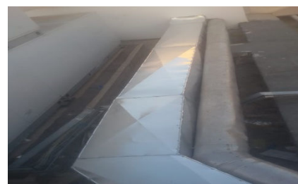
Bank Elmaghreb à Rabat: Modification de Fourniture et pose des jacketage en alu des gaines rectangulaires- Ventec Maroc
