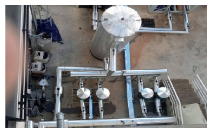
Usine Magneti Marelli à Tanger Med: Fourniture et pose Jacketage alu des réseaux aerauliques et hydrauliques- Ventec Maroc
