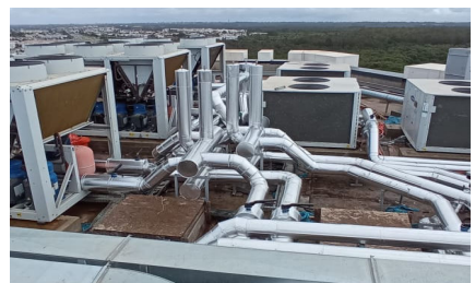
ANCFCC à Rabat: Fourniture et pose des jackettage en alu des gaines rectangulaires et réseaux hydrauliques pour Batiments IGH: Tour1 ( R+14 etages), Tour2 (R+ 6 etages), Tour 6 (R+ 7etages), Tour 7 ( R+8 etages) et Mi-centrale R+1 et travaux de jackettage en inox pour local chaufferie - Client Ventec Maroc
