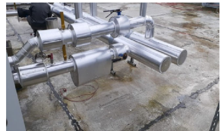
Tribunal à Tanger: Pose seulement de jackettage en alu des réseaux Eau glacée- Client Ventec Maroc
