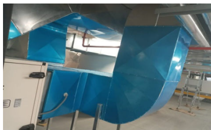
Tour BCP à Casablanca city financier: Fourniture et pose des jackettage en alu des gaines rectangulaires du local technique CTA- Client Ventec Maroc
