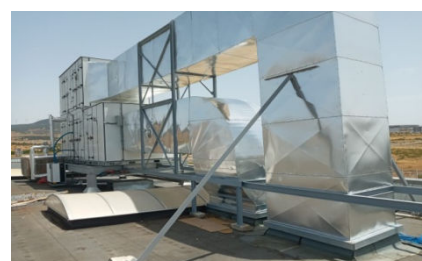
Salle Blanche à Tanger Med: Fourniture et pose Jacketage alu des réseaux aerauliques et hydrauliques- Ventec Maroc
