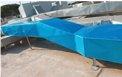
Hotel Radisson Blu Al-houciema: Fourniture et pose Jackettage alu des réseaux aerauliques et hydrauliques- Ventec Maroc
